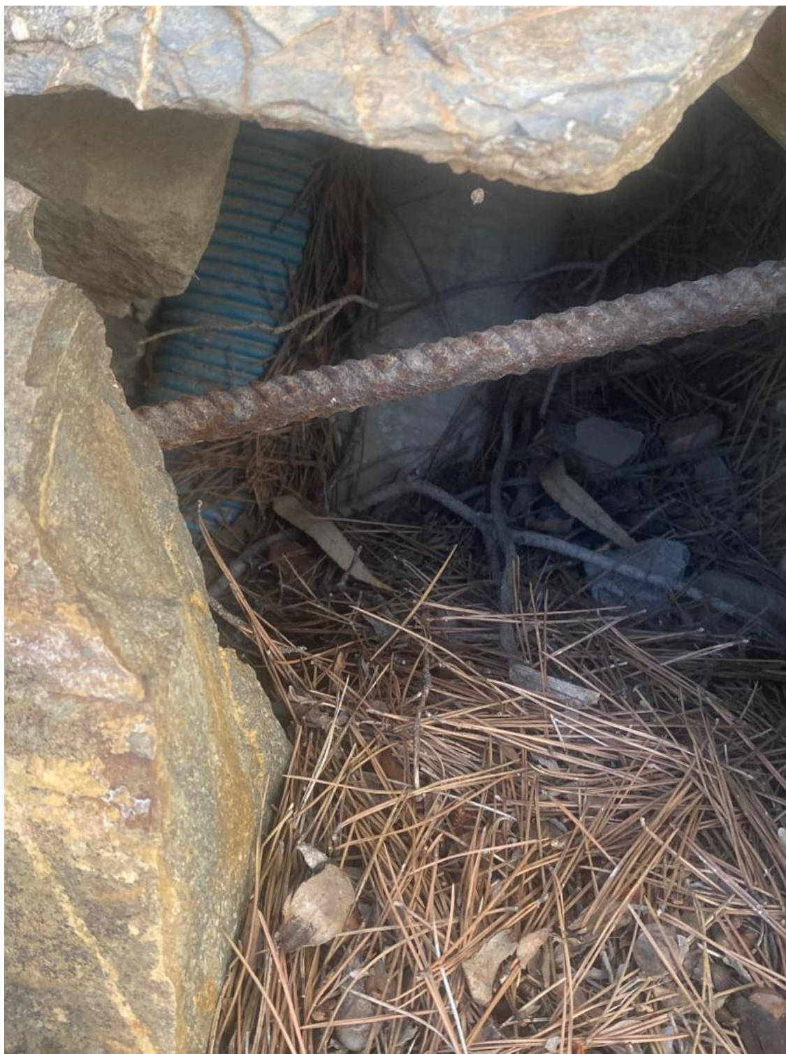
3 Tubería Fibrocemento conexión Aljibes 1 y 2
